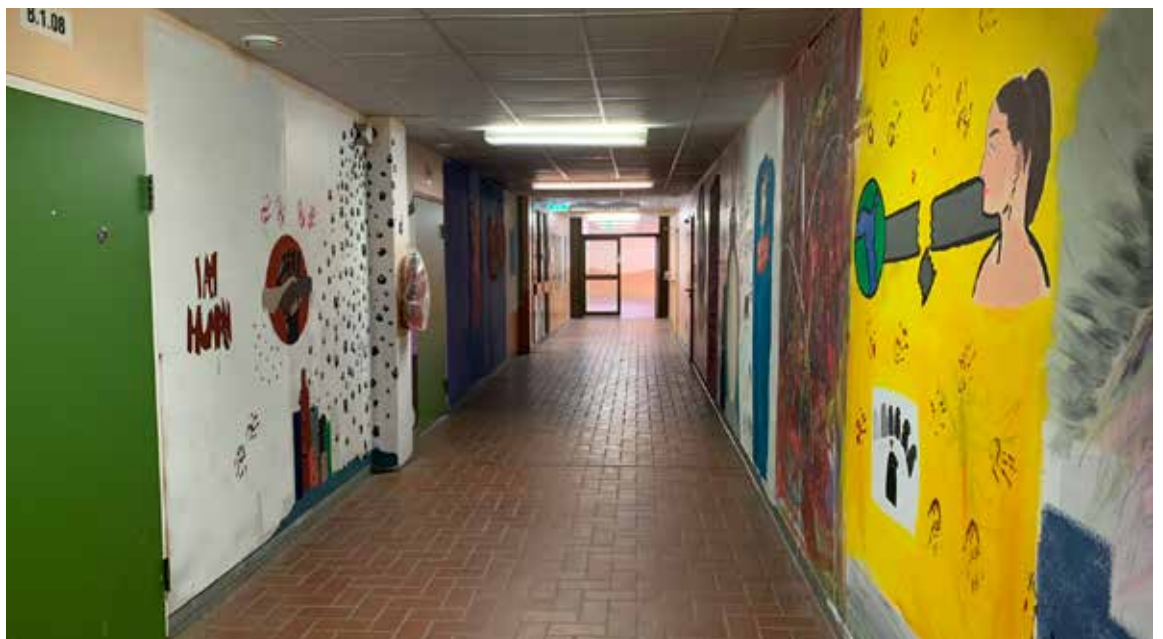
Bemalte Wände in einem alten Gebäudeteil der Mathildenschule
